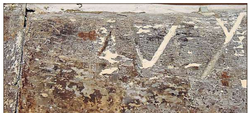
Römischen Zahlen und Zeichen hatte der Baumeister seinerzeit zur Kennzeichnung der einzelnen Balken genutzt.
