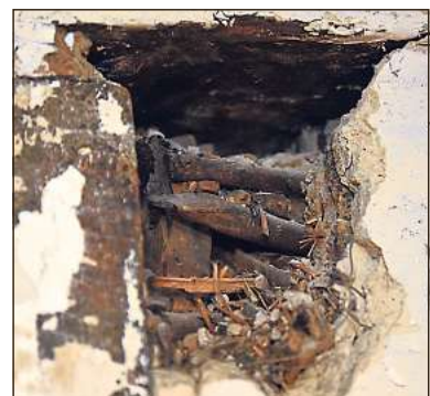
Das freigelegte Mauerwerk zeigt den Stützbalcken, der mit Weidenholz umflochten wurde.
