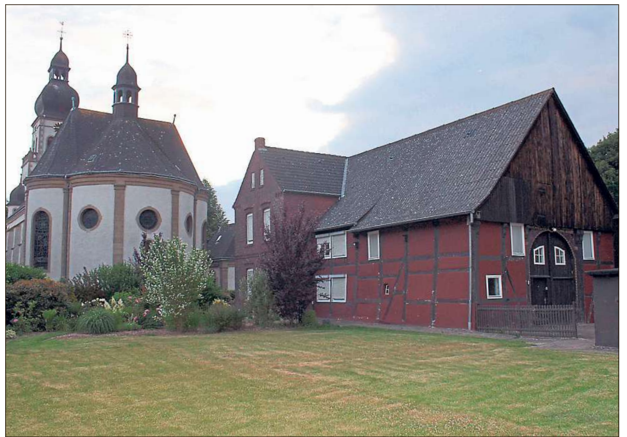
Appartement, Archiv, Pfarrbüro und mehr sollen im spätestens 2021 im sanierten Küsterhaus untergebracht werden. Die Kosten werden mit annähernd 400 000 Euro beziffert. Bilder: Daub
