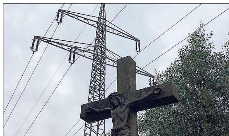
110 000 Volt Spannung führt die Freileitung, an der sich die nächtliche Lichterscheinung ereignete. Bild: von Stockum
