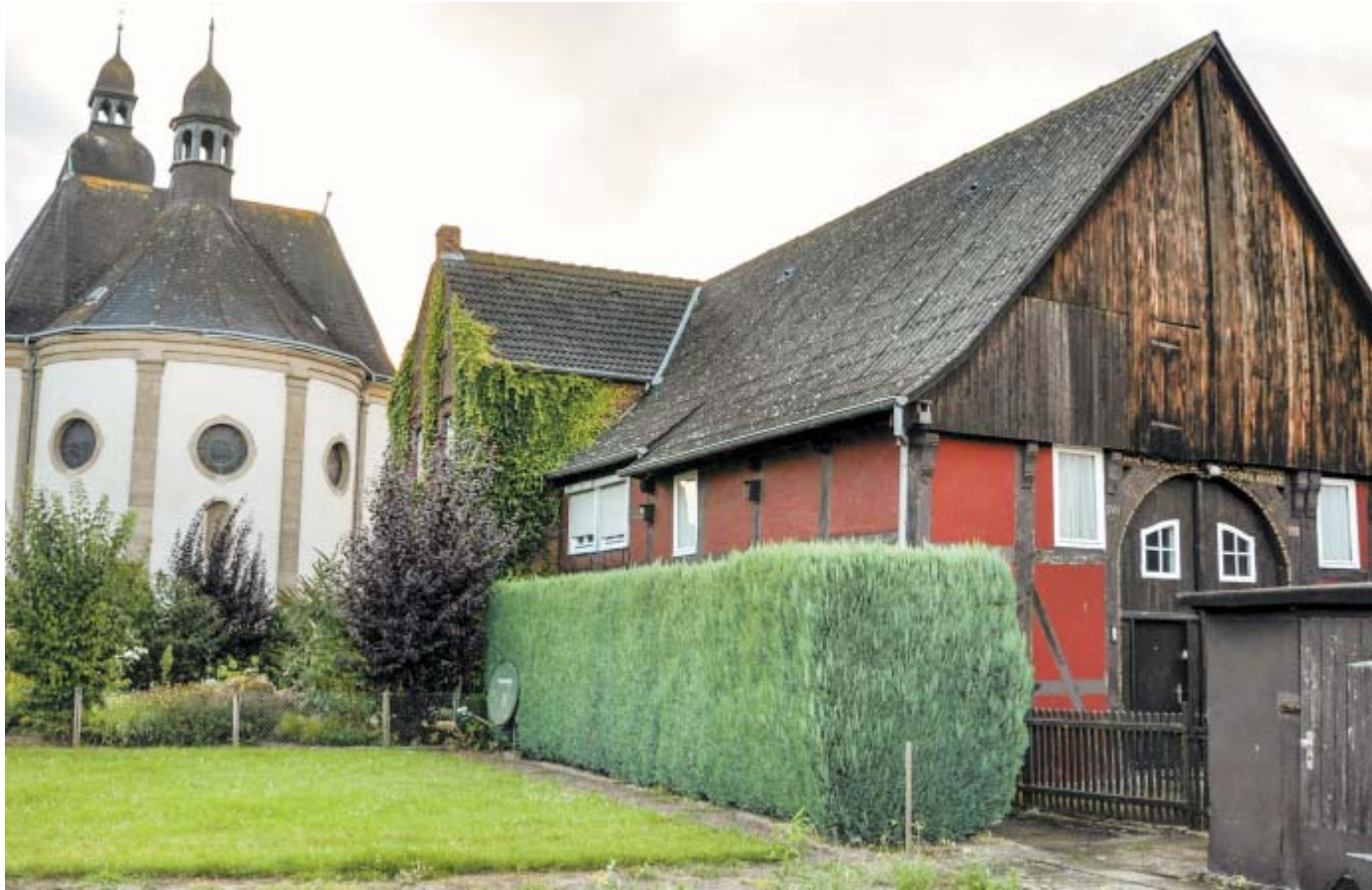
Soll ab Herbst umgebaut werden: Das alte Küsterhaus soll eine Stätte der Begegnung und Bildung werden und Gäste beherbergen.
