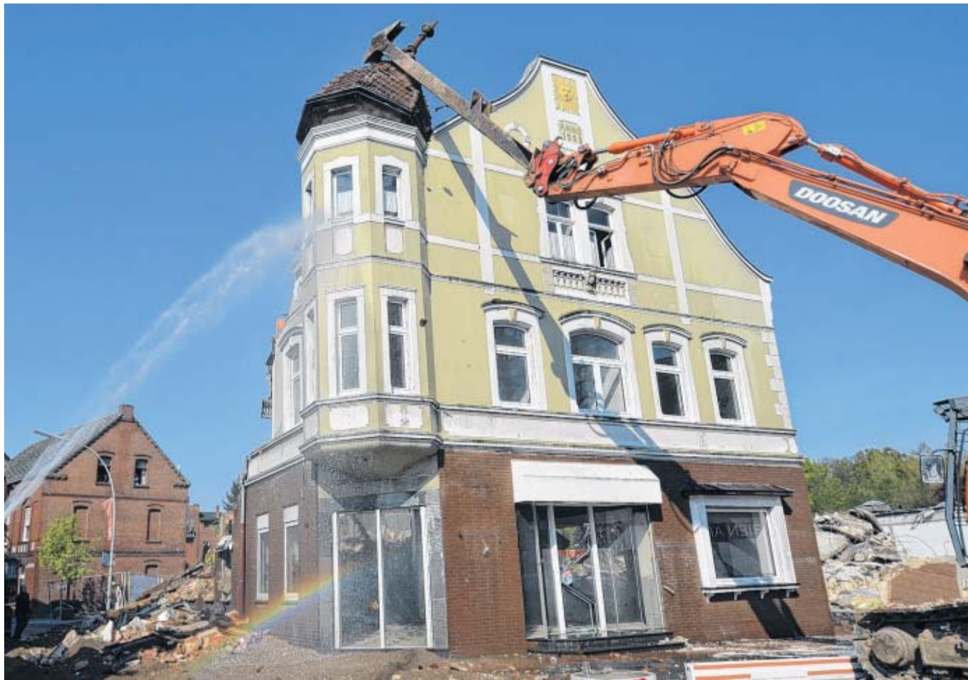
Ende einer Ära: Das alte Becker-Haus, früher jahrzehntlang das wichtigste Veranstaltungszentrum im Wapeldorf, ist gestern Morgen abgerissen worden. FOTOS: BIRGIT VREDENBURG
