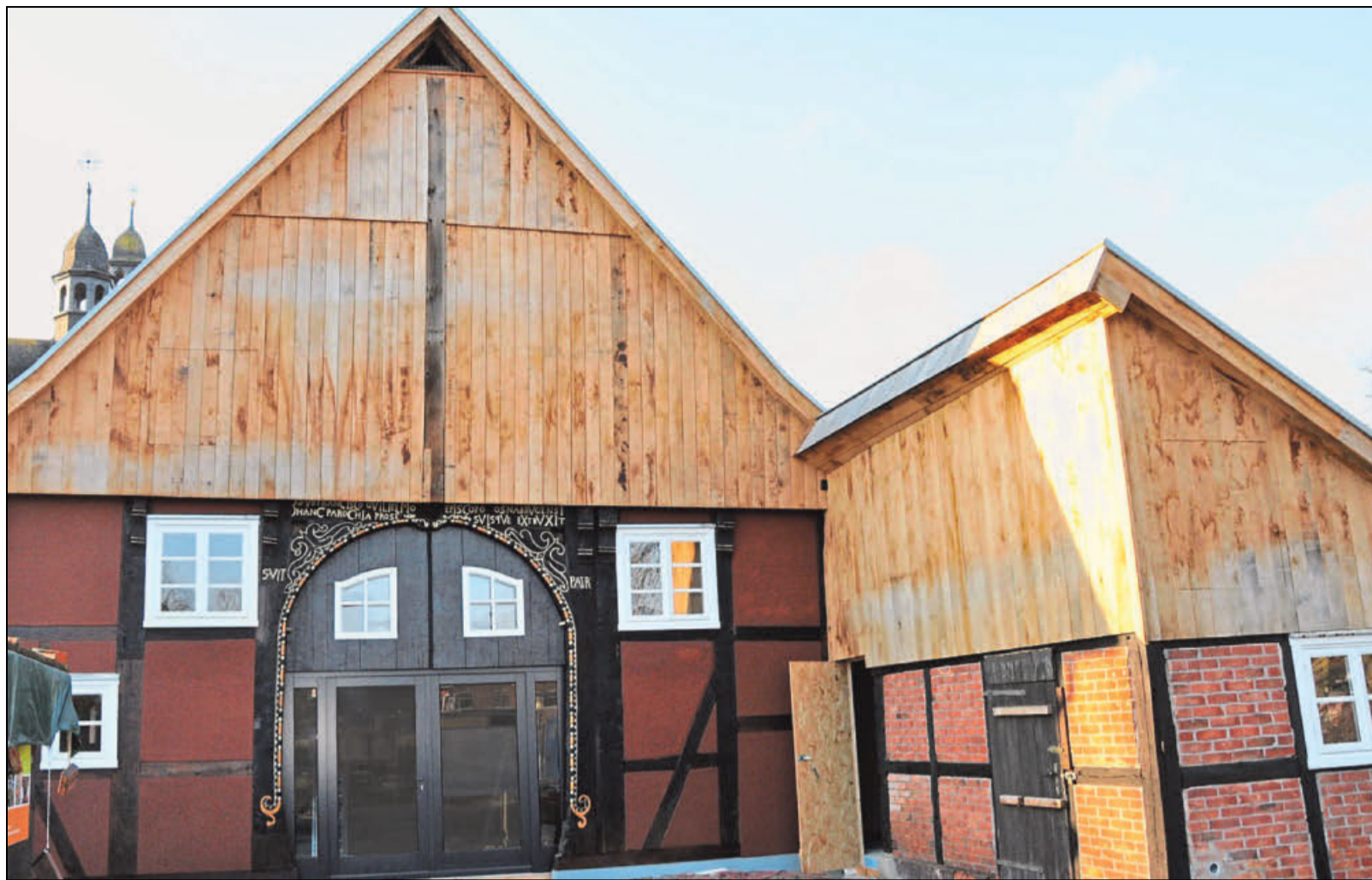
Die Außenarbeiten am Haus sind abgeschlossen. Jetzt geht es an den Innenausbau. Auch für die künftige Nutzung sind schon Pläne geschmiedet worden. Neben einer Einliegerwohnung wird auch das Pfarrbüro dort einziehen. Fotos: Waltraud Leskovsek
