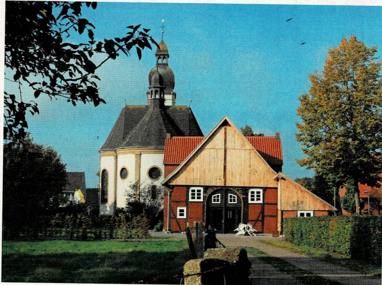
Ein schönes Ensemble: Die Außenrenovierung ist abgeschlossen.
