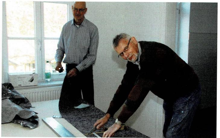
▲ Heinrich Splietker und Hermann Josef Budde im Dachgeschoss beim Zuschneiden von Bodenplatten zum Abdecken der unter dem Teppichboden liegenden Holzfügen
